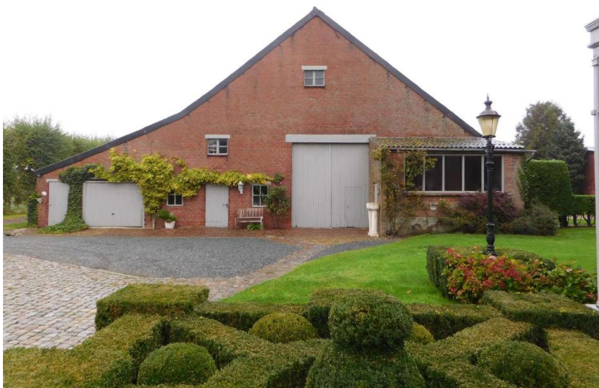
Figuur 8 - Voorgevel van de voormalige landbouwschuur Nieuwe Dijk 1 met rechts het 'machinehok'.
