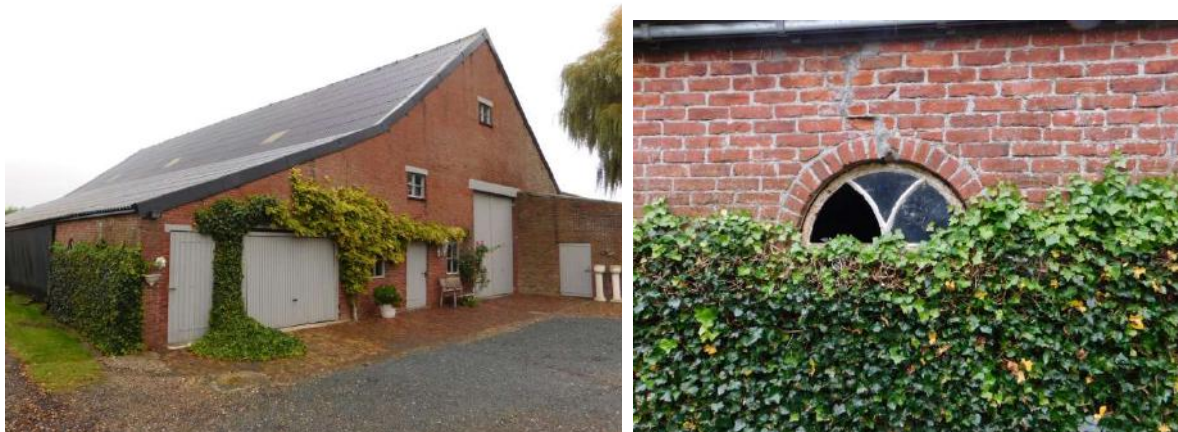
Figuur 9 - (links) Voorgevel en linker zijgevel (ged.); (rechts) gietijzeren boogvenstertje.
