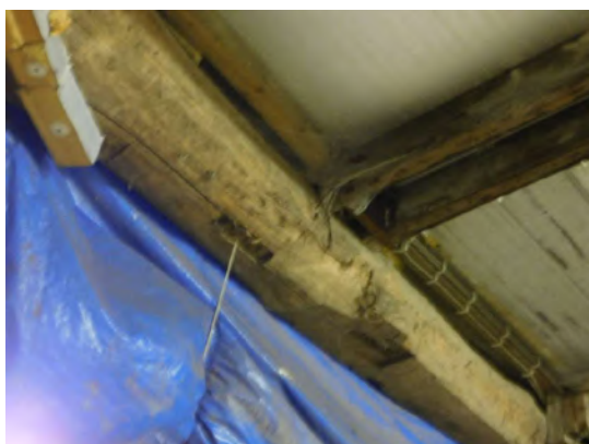
Figuur 13 - Gebintbalk - de rechthoekige gaten bewijzen dat deze balk is hergebruikt
