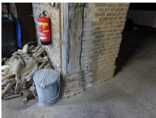
Figuur 12 - houten gebintstijl op gemetselde poer.
