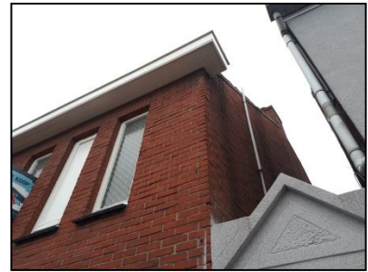
Figuur 11. Dak detail Dorpsstraat 30, Ossendrecht.
