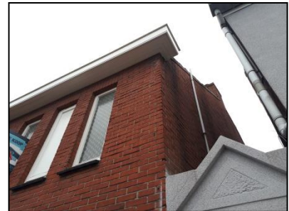
Figuur 11. Dak detail Dorpsstraat 30, Ossendrecht.
