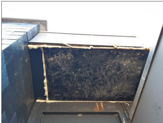
Foto 8 Houten omlijsting afgedicht met purschuim
