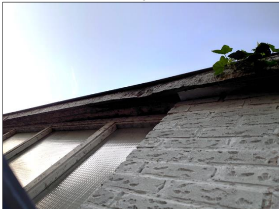
Foto 19: Detail onderzijde gevel westzijde
