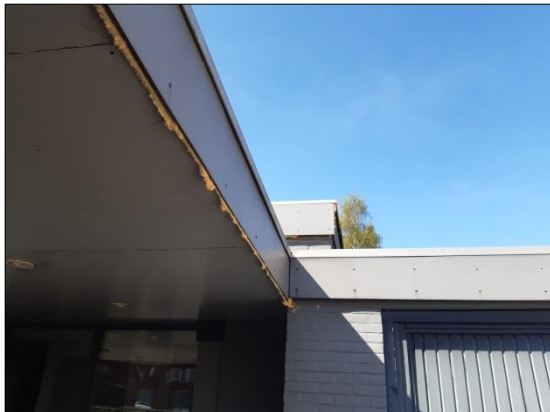
Foto 7 Houten omlijsting afgedicht met purschuim
