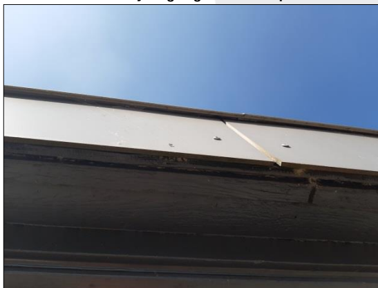
Foto 6 Houten omlijsting afgedicht met purschuim
