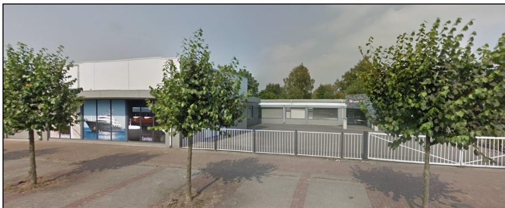
Aanzicht bestaande bebouwing ter hoogte van de Westerstraat 4a te Huijbergen. Bron: google.nl/maps.
