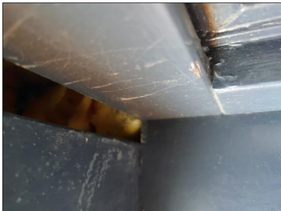
Foto 17: Detailfoto 3 grote spleet bij raamkozijn (isolatie zichtbaar)
