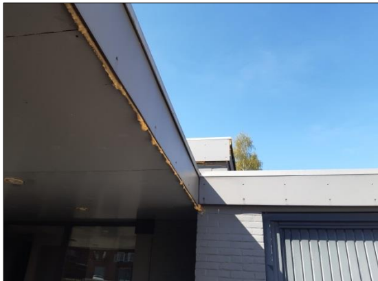
Foto 7 Houten omlijsting afgedicht met purschuim
