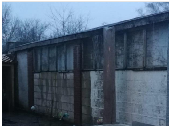
Foto 18: Gevel aan westelijke zijde
