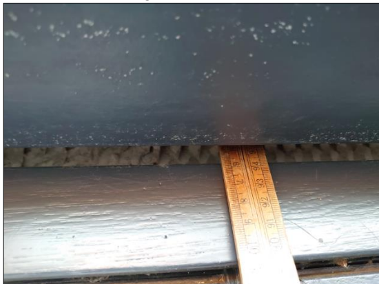
Foto 17: Detailfoto 3 grote spleet bij raamkozijn (isolatie zichtbaar)
