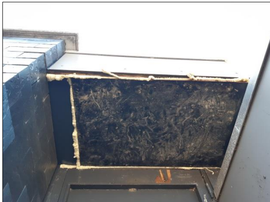
Foto 8 Houten omlijsting afgedicht met purschuim
