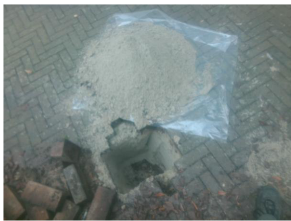
Foto 6. Asbestinspectiegat A6
