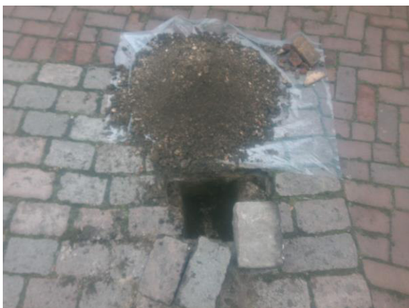
Foto 11. Asbestinspectiegat A11
