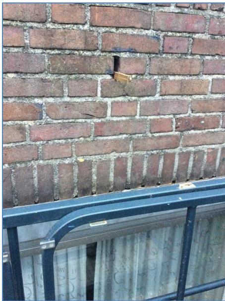
De open stootvoeg die toegang biedt tot het kraamverblijf
