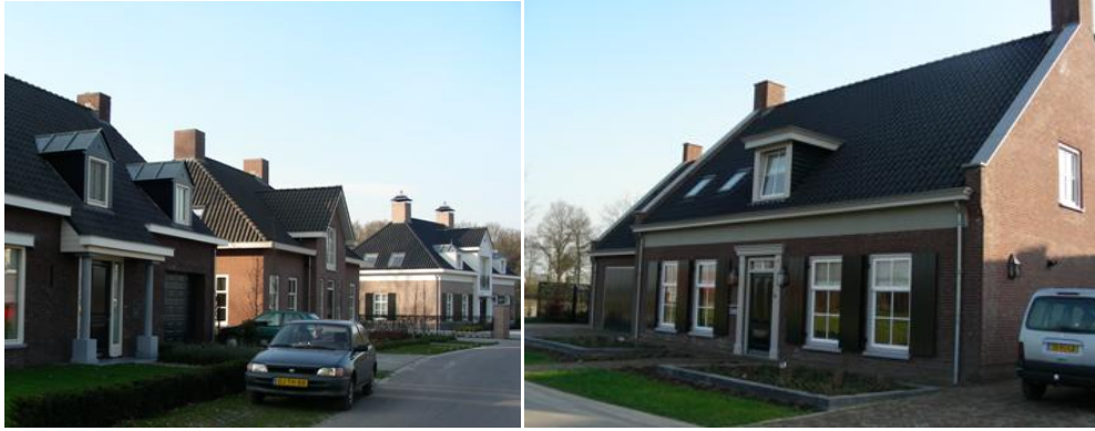
Figuur 4: Diverse notabele woningen in een straat en historiserende variant
