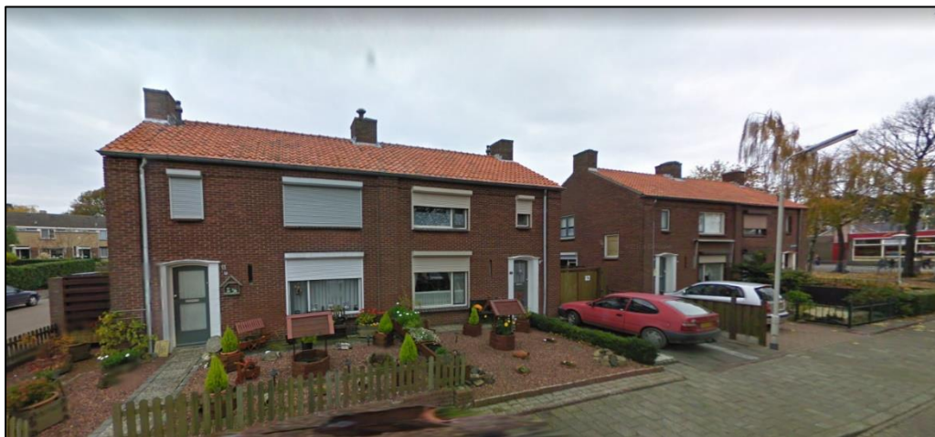
Aanzicht bestaande bebouwing vanuit de Molenakkers te Woensdrecht. Bron: google.nl/maps , 2020.
