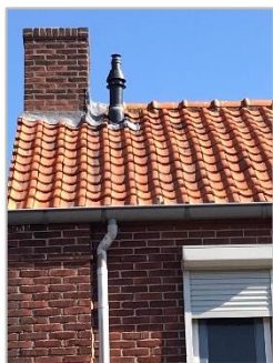
Foto 14: Schoorsteen en dakrand.
