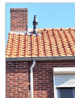
Foto 13: Dakrand en schoorsteen.
