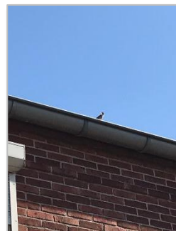
Foto 25: Mannelijke huismus in dakgoot.
