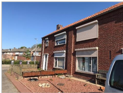
Foto 2: Voorzijde van de te slopen woningen .
