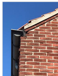
Foto 19: Overgang dakrand naar goot, dichtgezet met gaas.
