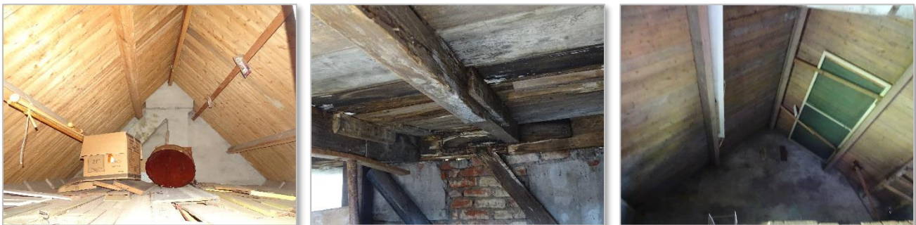
Foto 25, 26 en 27: In binnenruimtes werden geen vleermuizen of sporen (uitwerpselen) van vleermuizen aangetroffen.
