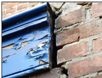
Figuur 11. Geschikte openingen voor vleermuizen
