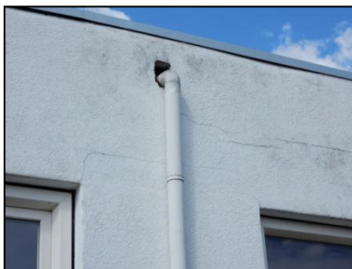
Figuur 10. Geschikte openingen voor vleermuizen
