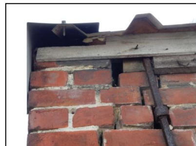
Figuur 12. Geschikte openingen voor vleermuizen
