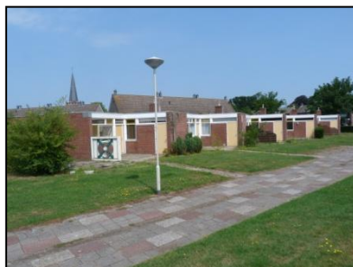
Figuur 7. Voorzijde (middelste) woningblok.
