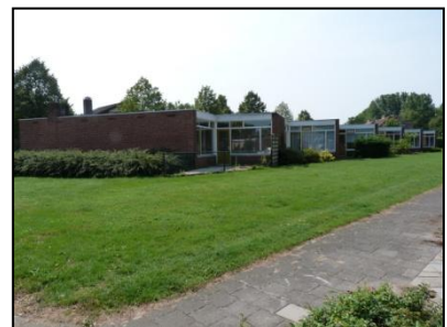
Figuur 8. Achterzijde (oostelijk) woningblok.
