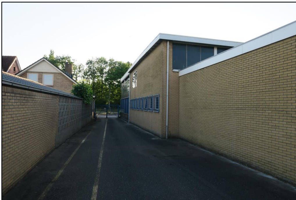
Figuur 2 Zuidzijde van gebouw A welke bestaat uit gemetselde muren met plat dak en daklijsten.
