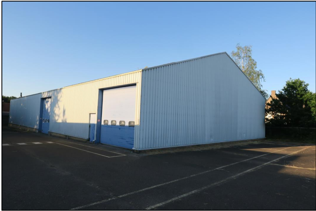
Figuur 3 Gebouw B van de planlocatie, deze bestaat uit metalen damwanden en een bitumen, schuin aflopend, dak.
