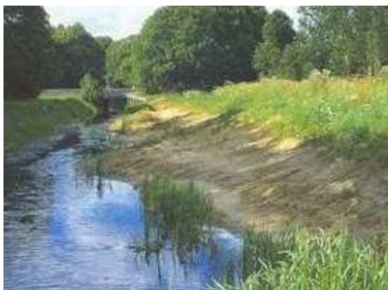
Waterloop met flauw talud
