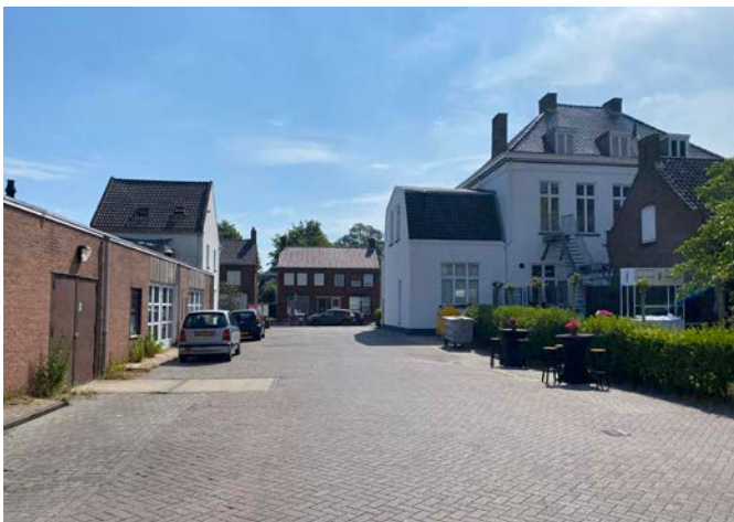
Figuur 3.9: Raadhuisstraat gezien vanaf achterterrein
