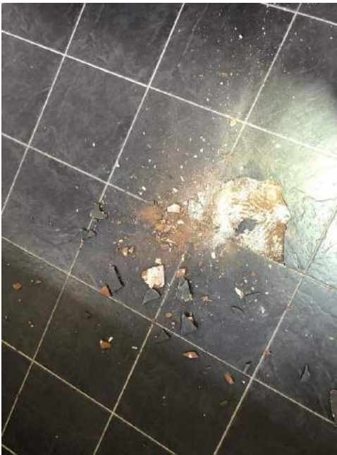
Impressie destructief onderzoek onder vaste vloerafwerkingen.
