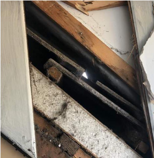
Zijwangen van dakkapel zijn van volkern materiaal.
