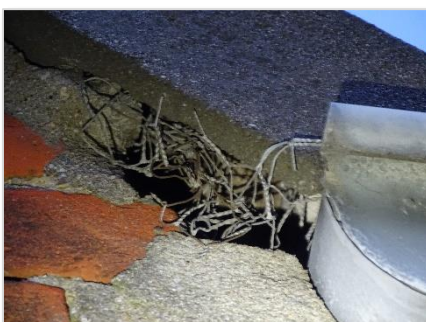
Foto 38: Openingen langs dakrand kopse kanten woningen (bij dakgoot).
