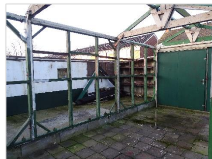
Foto 19: Impresie bebouwing plangebied (schuurtje dak reeds verwijderd).
