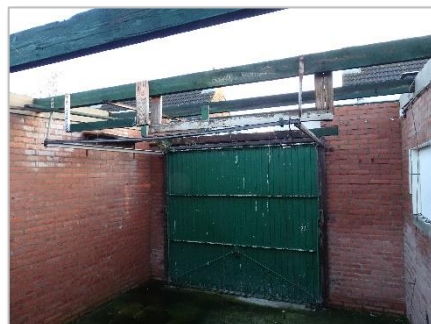
Foto 22: Impresie bebouwing plangebied (stenen garage, dak reeds verwijderd).
