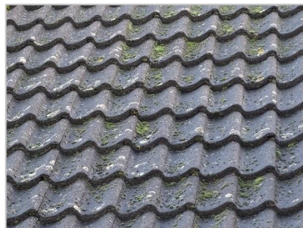
Foto 27: Dakbedekking woningen ('sneldekkers' zonder tussenruimte).
