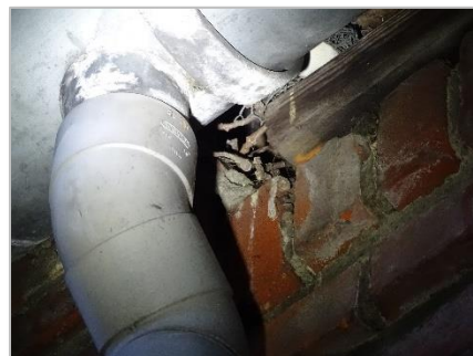
Foto 39: Openingen langs dakrand kopse kanten woningen (bij dakgoot).
