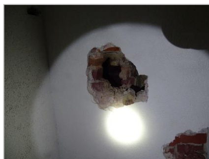
Foto 40: Binnenzijde woning (schoorsteenruimte geopend i.v.m. asbest).
