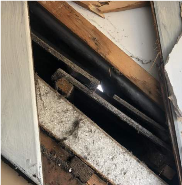
Zijwangen van dakkapel zijn van volkern materiaal.
