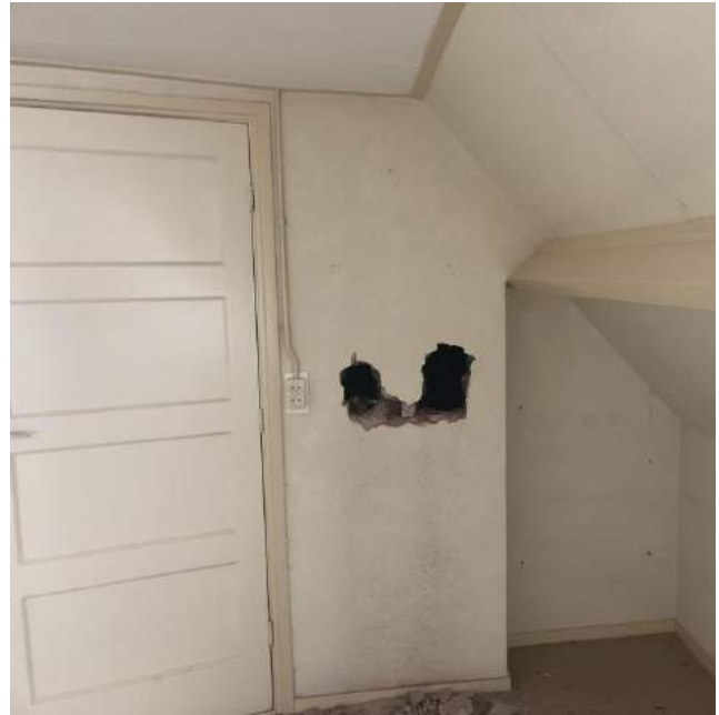
Impressie destructief onderzoek rookgaskanalen.
