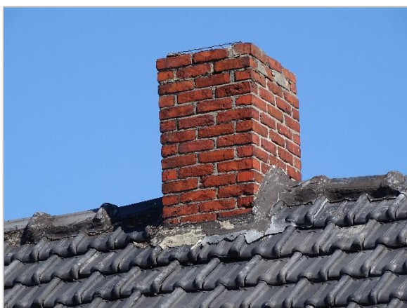
Foto 11: Impressie dakbedekking woning Onderstal 14 te Hoogerheide.
