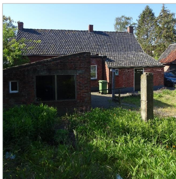
Foto 2: Impressie ligging plangebied Onderstal 14 te Hoogerheide (woning achterzijde en bijschuur).
