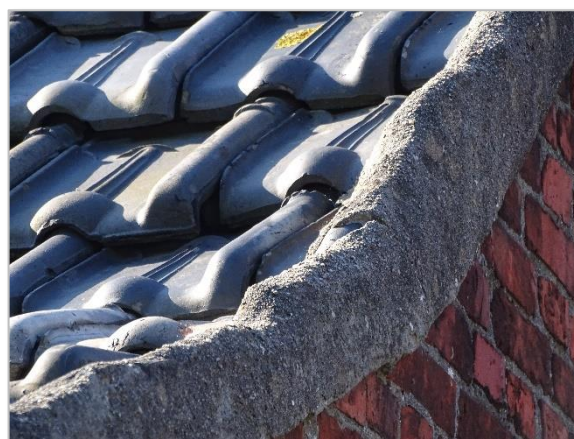
Foto 10: Impressie dakbedekking woning Onderstal 14 te Hoogerheide.
