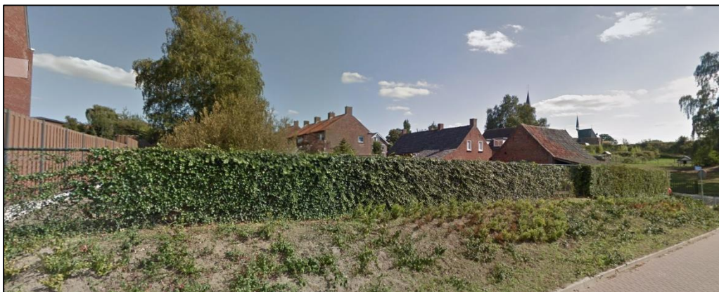
Aanzicht bestaande bebouwing ter hoogte van de Onderstal 14 te Hoogerheide. Bron: google.nl/maps, 2020.
