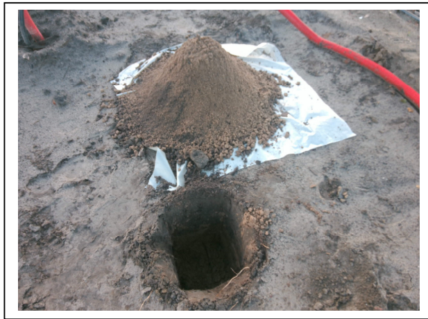
Foto 4. Asbestinspectiegat 04
