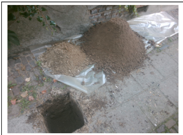
Foto 17. Asbestinspectiegat 17
