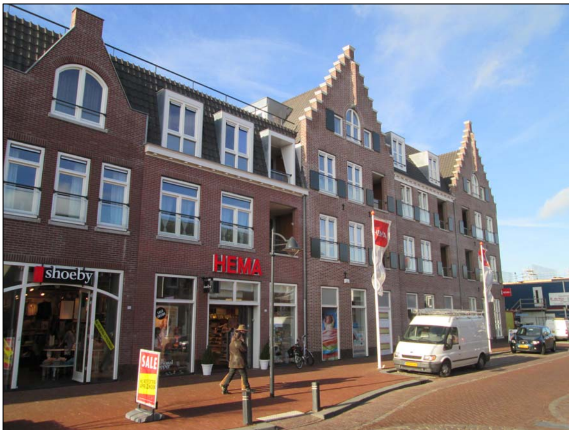
Reeds gerealiseerd deelplan aan de Raadhuisstraat. Het voorliggende plan maakt eveneens deel uit van de herontwikkeling van het Raadhuisplein.
