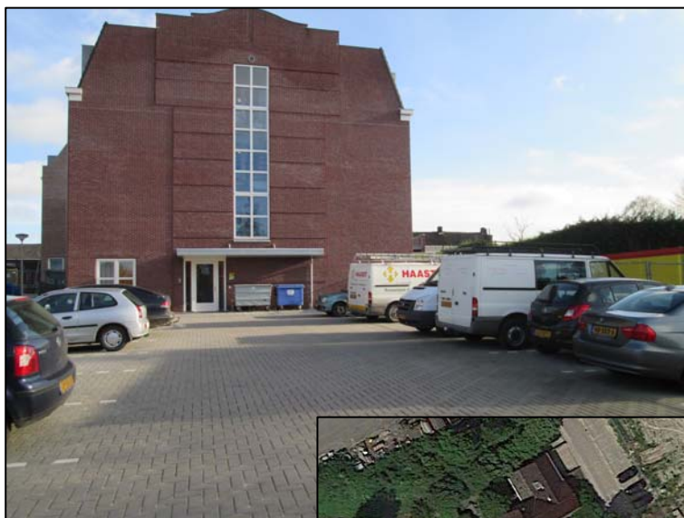
Zijgevel nieuwbouw plandeel B en plangebied ingericht als parkeerterrein
