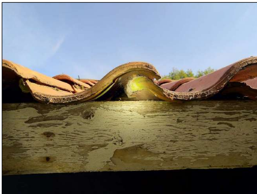
Figuur 10. De ruimte onder de dakpannen loopt door tot aan de nok van de schuur.
