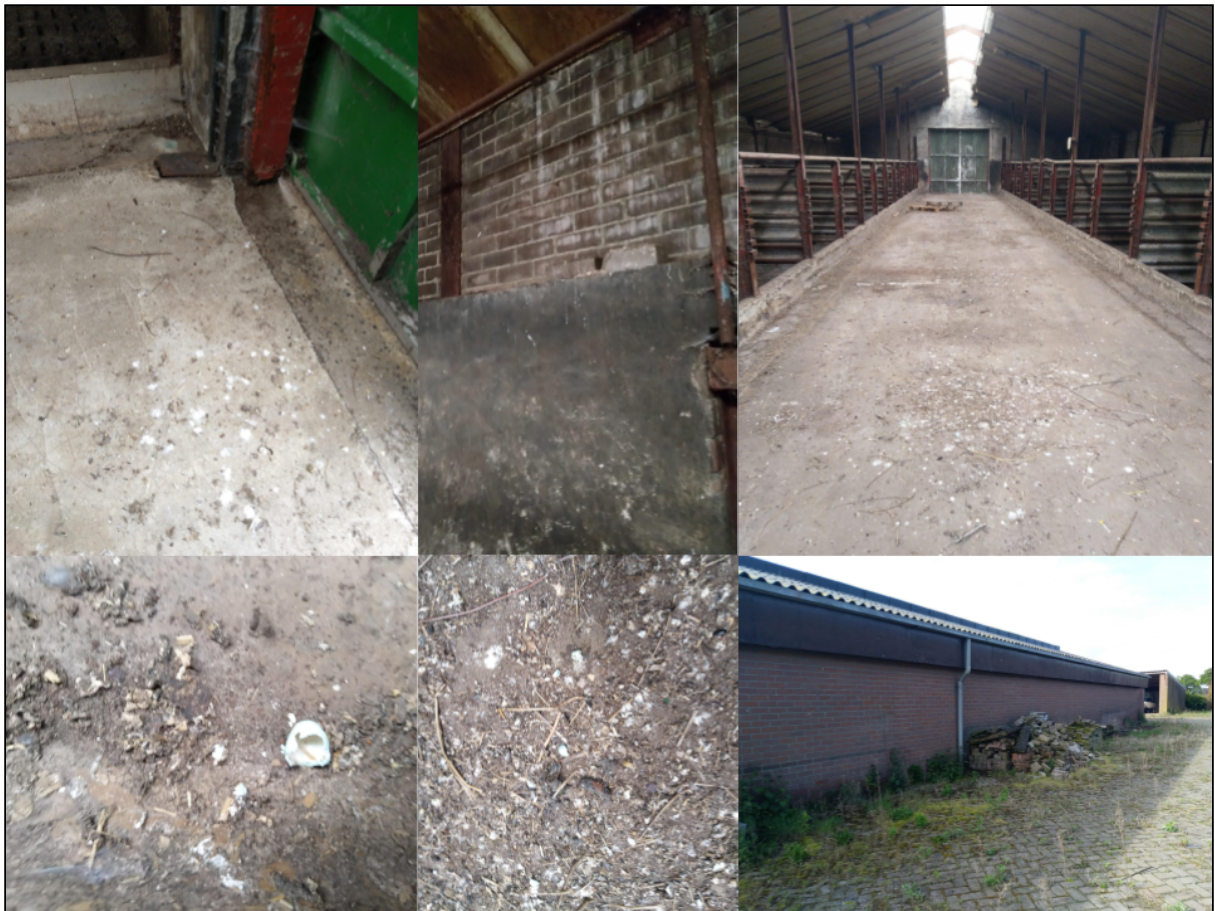
Afbeelding 3: Indruk van loods / stal 1 van 4 (zie afbeelding 2). De stal is leeg, niet in gebruik. De gevonden sporen betreffen oude sporen. De muren zijn enkelsteens en het dak is opgebouwd uit 1 laag.
