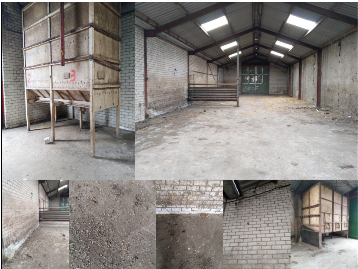
Afbeelding 5: Overzicht van Loods / stal 3 van 4. Ook deze loods / stal is niet in gebruik, is kaal en leeg. De gevonden sporen zijn oud.
