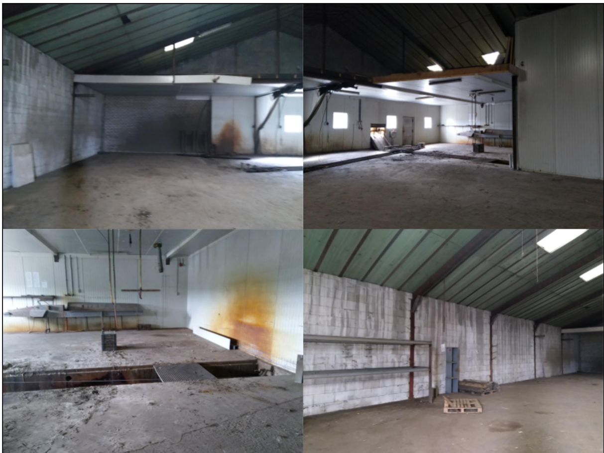
Afbeelding 4: Overzicht van Loods / stal 2 van 4. Ook deze loods / stal is niet in gebruik, is kaal en leeg.
