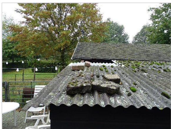
Foto 5: Impressie optioneel te slopen Schuur 1. (dakbedekking)
