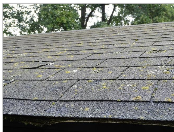
Foto 6: Impressie optioneel te slopen Schuur 1. (dakbedekking)
