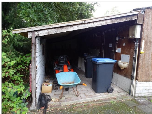
Foto 19: Impressie te slopen open aanbouw grote schuur.
