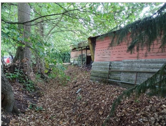
Foto 21: Impressie te slopen open aanbouw grote schuur. (achterzijde grenzend aan de Blikloop)
