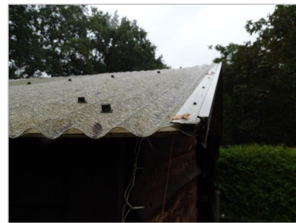
Foto 12: Impressie optioneel te slopen Schuur 2. (dakbedekking)
