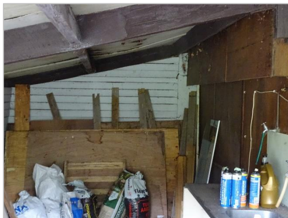
Foto 20: Impressie te slopen open aanbouw grote schuur. (interieur)
