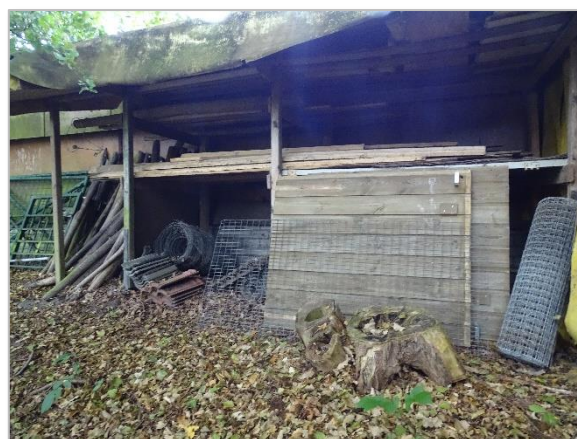
Foto 22: Impressie te slopen open aanbouw grote schuur.
