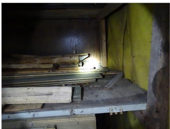
Foto 23: Impressie te slopen open aanbouw grote schuur. (interieur)
