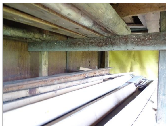
Foto 24: Impressie te slopen open aanbouw grote schuur. (interieur)
