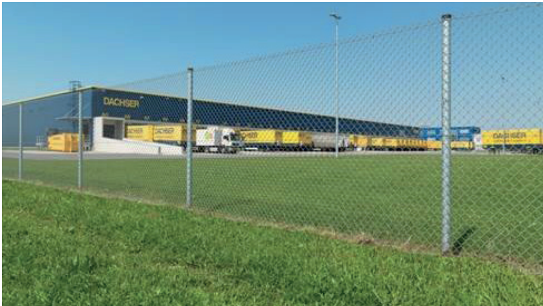
Afbeelding 10. Referentiebeeld van een transparant hekwerk. Kleuren van de staanders dienen donkergroen te zijn.
