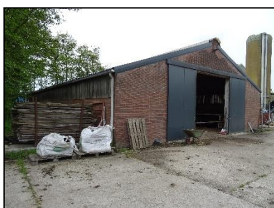
Figuur 10. Open koeienstal op de onderzoekslocatie.
