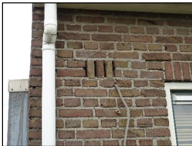
Figuur 25. Open ventilatiesleuven in de woning op de onderzoekslocatie.
