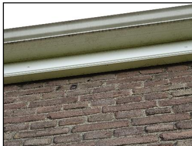
Figuur 26. Ruimte onder de dakrand bij de woning op de onderzoekslocatie.
