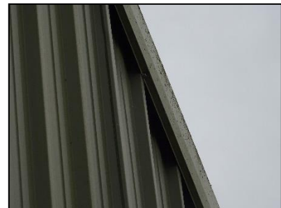
Figuur 27. Ruimte onder dakrand van de bedrijfsloodsen op de onderzoekslocatie.
