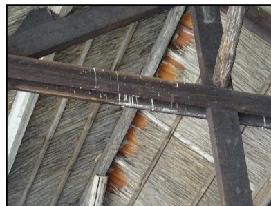
Figuur 24. Krijtstrepen op de balken in de open schuur op de onderzoekslocatie.
