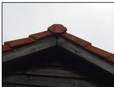
Figuur 19. Ruimte onder kant en nokpannen bij de open schuur op de onderzoekslocatie.
