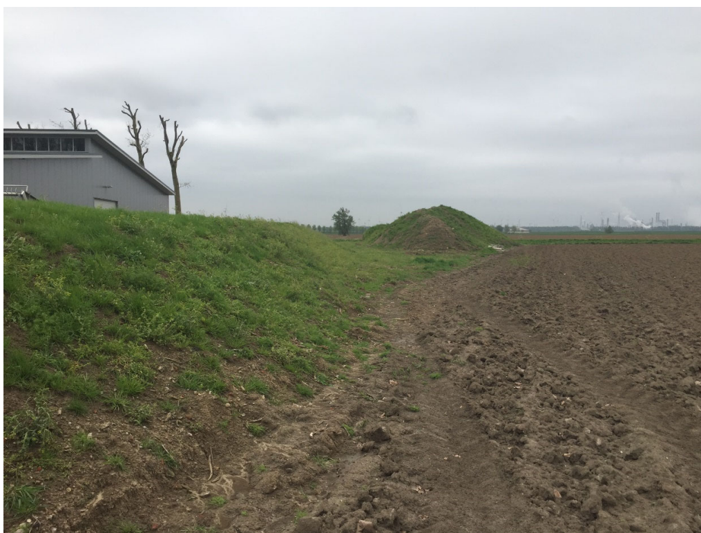
Figuur 2 Grondwal rond de bedrijfsbebouwing (ook zicht op tijdelijk gronddepot)
