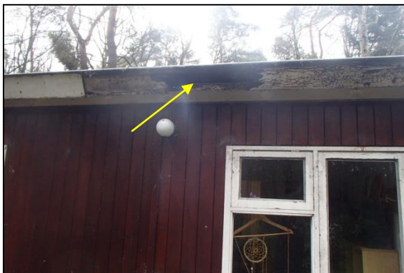
Figuur 17. Ruimte achter betimmering
