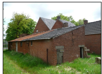
Figuur 6. Achterzijde woonhuis
