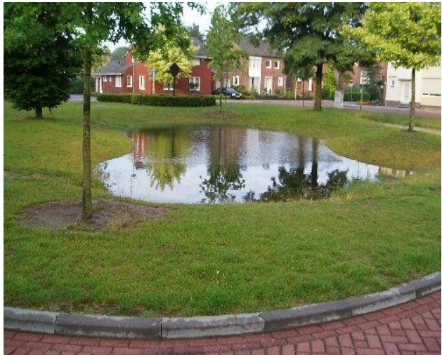
Afbeelding 11: Voorbeeld van infiltratie d.m.v. een wadi
