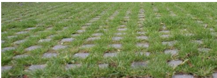
Afbeelding 14: Straategie - Betonnen grastegels (ontwerp te Heeswijk)
