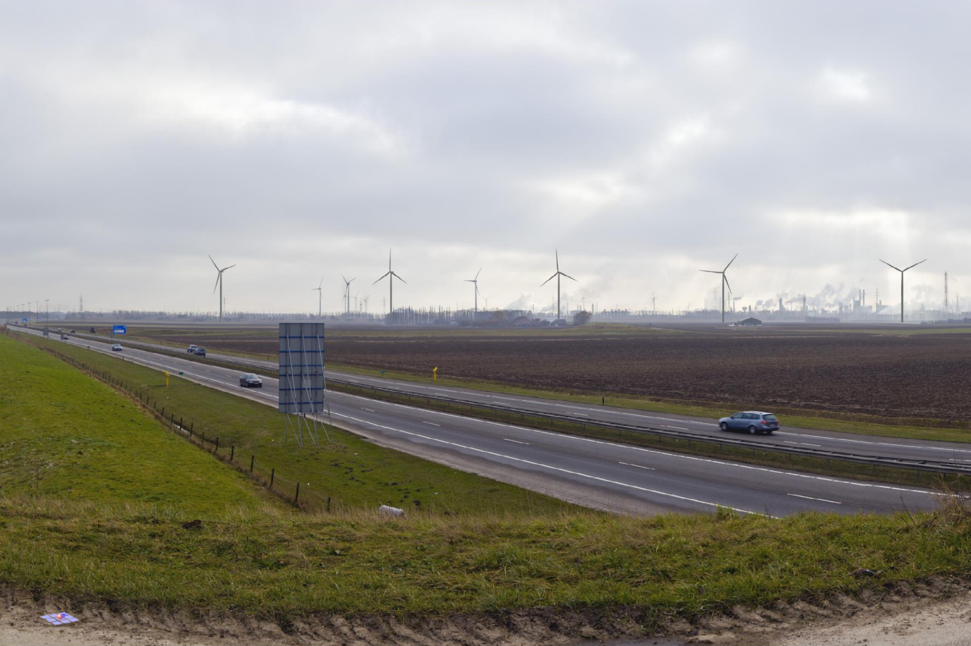
Locatie A met Windpark Kabeljauwbeek
