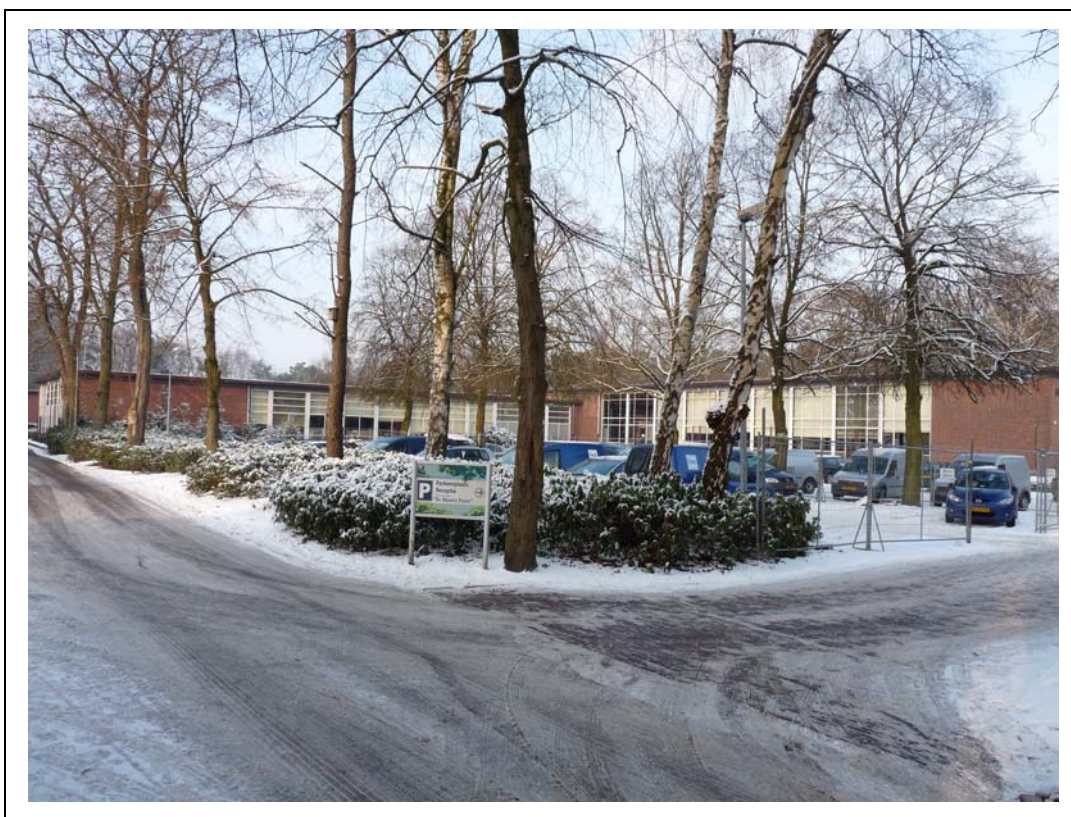
Foto 12. zuidelijk deel van deellocatie II, op achtergrond te slopen schoolgebouw
