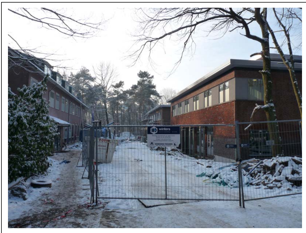
Foto 10. deelloctie III, links bestaande bebouwing rechts nieuwbouw
