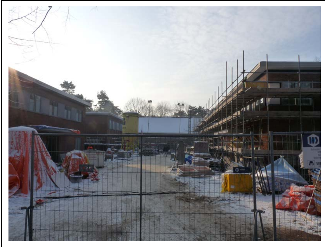
Foto 9. deelloctie III, werkzaamheden zijn in 2009 al gestart.
