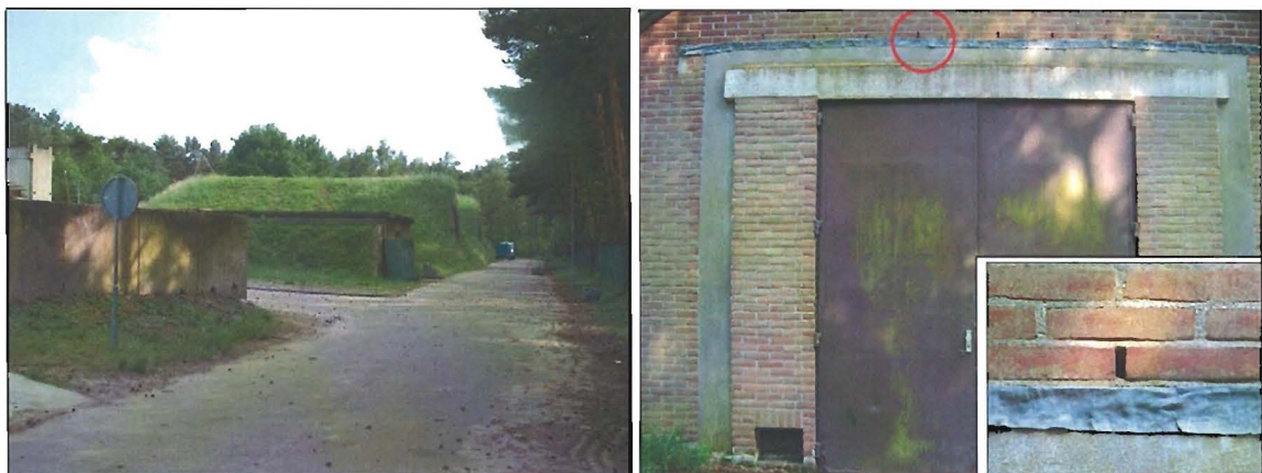
Figuur 2. Beeld van de kolonieplaats van de gewone dwergvleermuis in het reconstructiegebied van de politieacademie te Ossendrecht.
