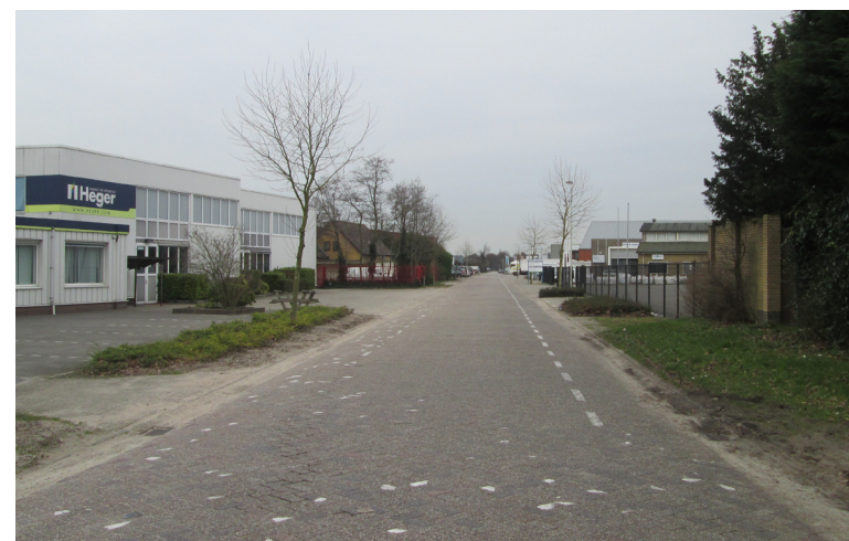
Bebouwingsbeeld huidige bedrijventerrein
