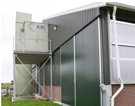
Stal met chemisch luchtwassysteem (bron: Rombou)
