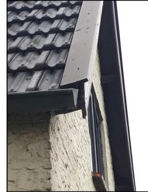
Figuur 13. Ruimte onder het houtwerk en de dakpannen.
