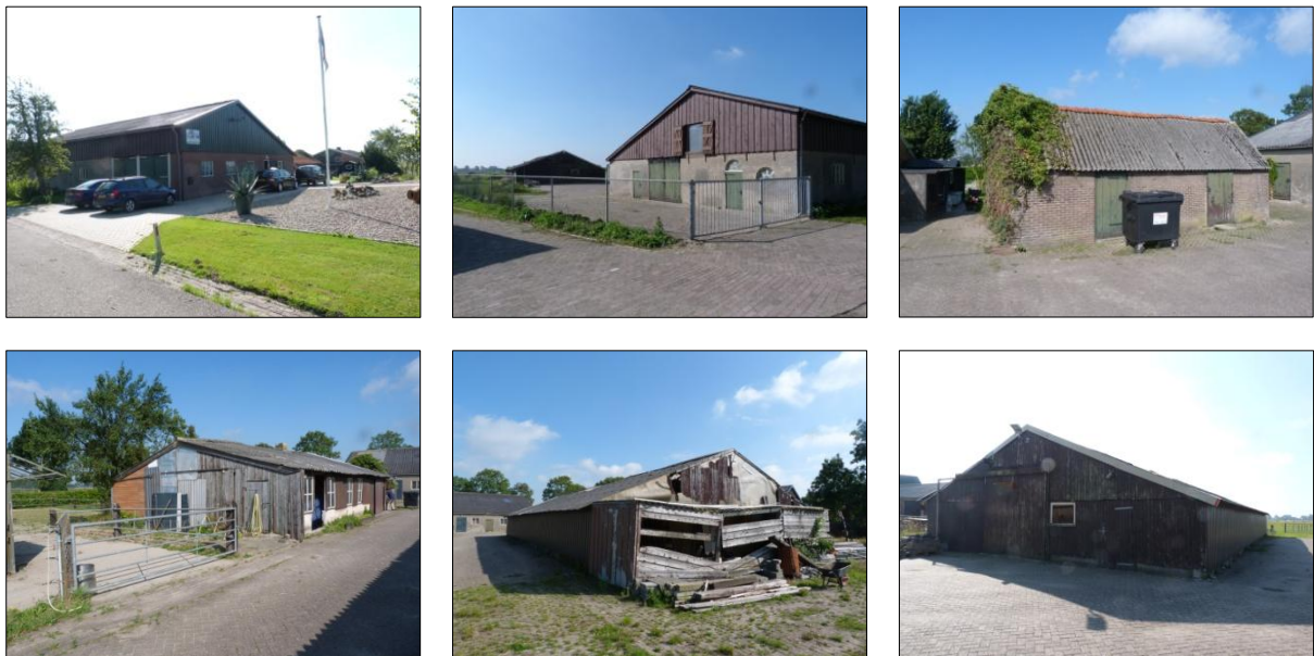
Figuur 2 t/m 7. Overzicht van de buitenzijdes van de te slopen schuren.
