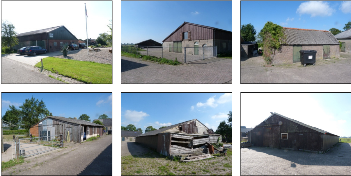
Figuur 1 t/m 6. Overzicht van de buitenzijdes van de te slopen schuren.
