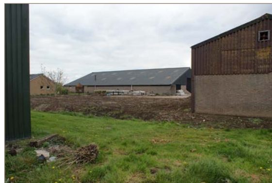
Figuur 15: Achterliggend terrein Zandsteeg 61 (akkerbouwbedrijf)
