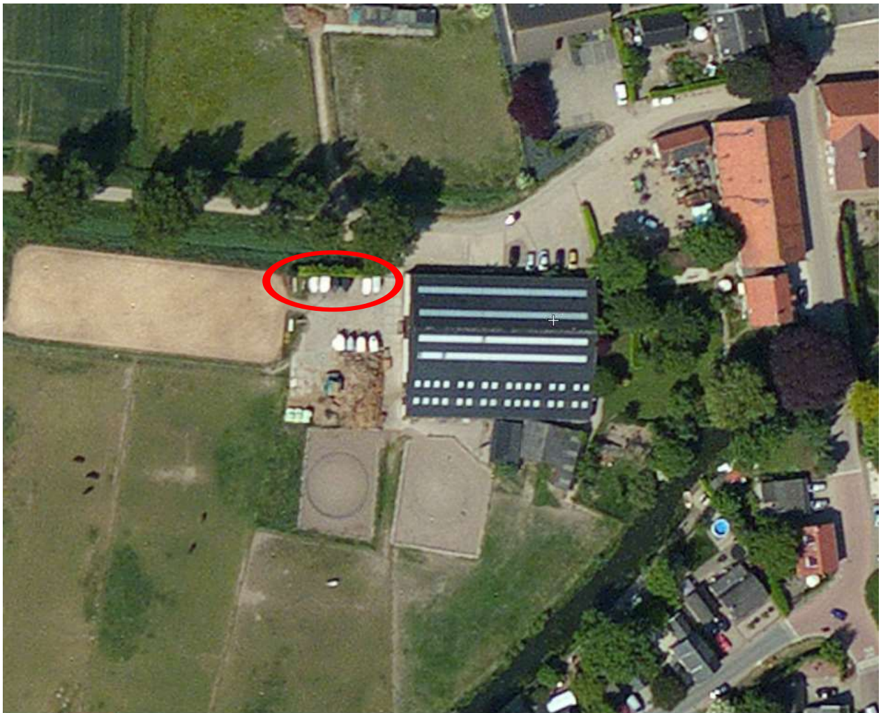
Figuur 19: te verwijderen groenelement
