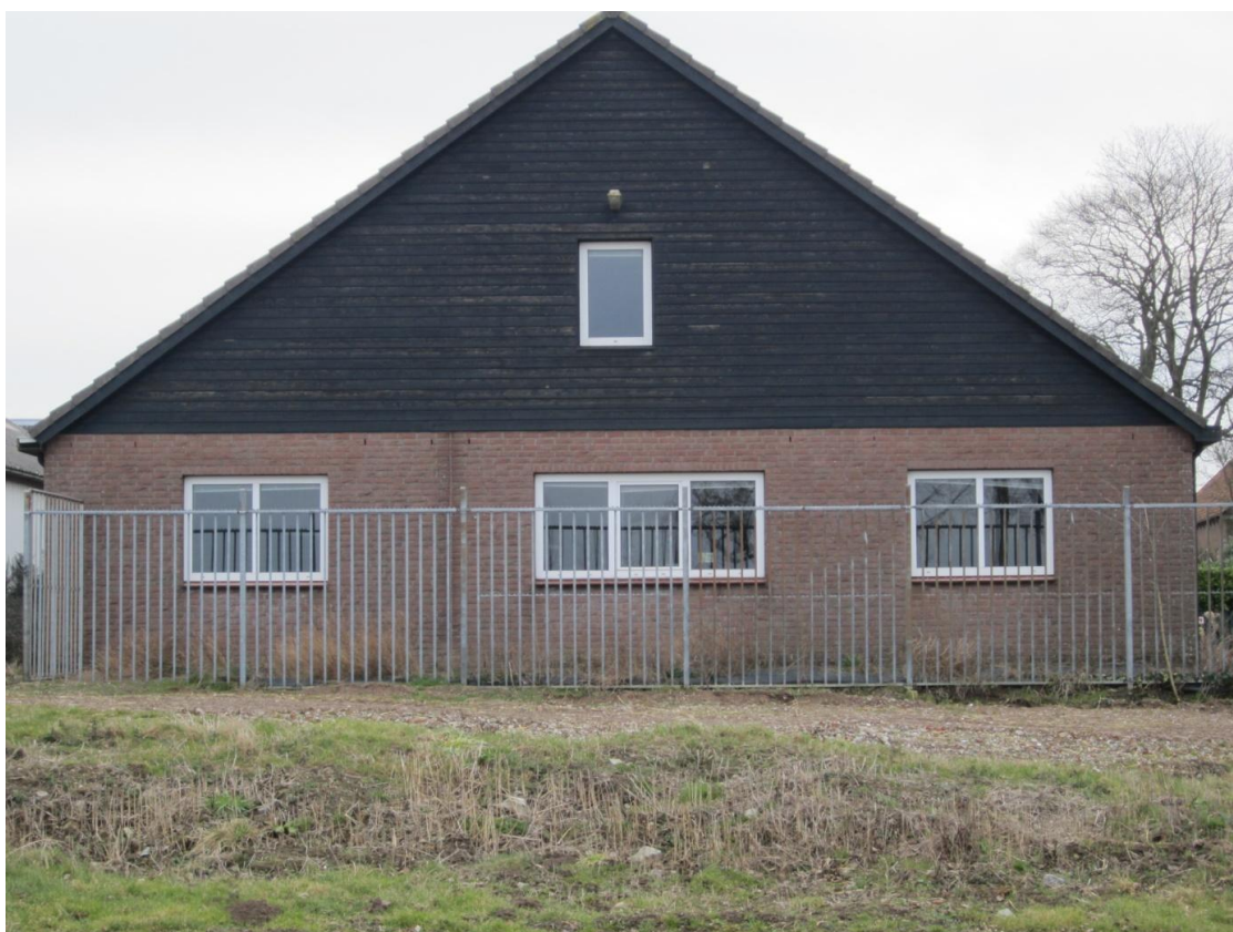
achtergevel voormalig kantoorpand/nieuwe woning
