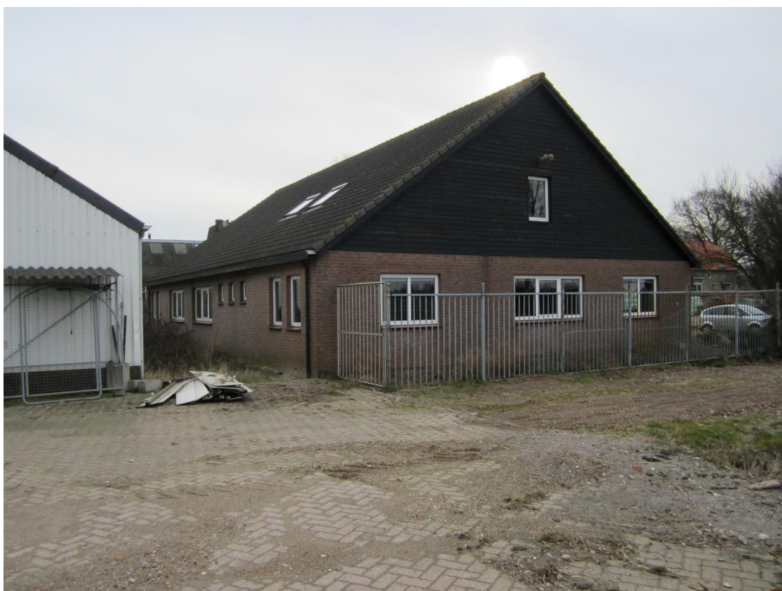
rechterzijgevel/achtergevel voormalig kantoorpand/nieuwe woning
