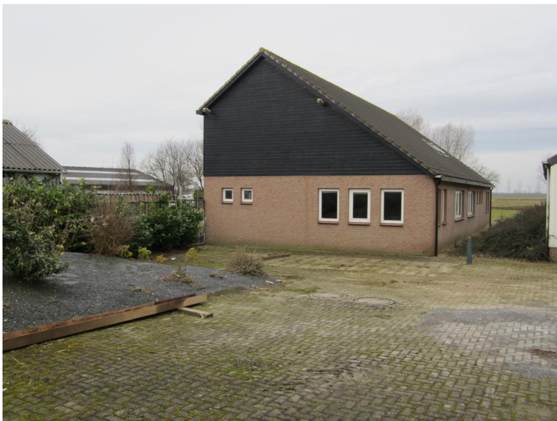
voorgevel voormalig kantoorpand/nieuwe woning
