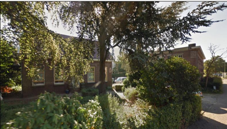
Bedrijfswoning ('t Zand 23)
