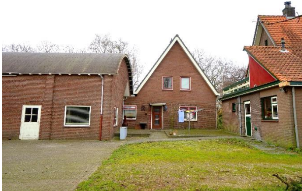
Achterste woning en werkloods
