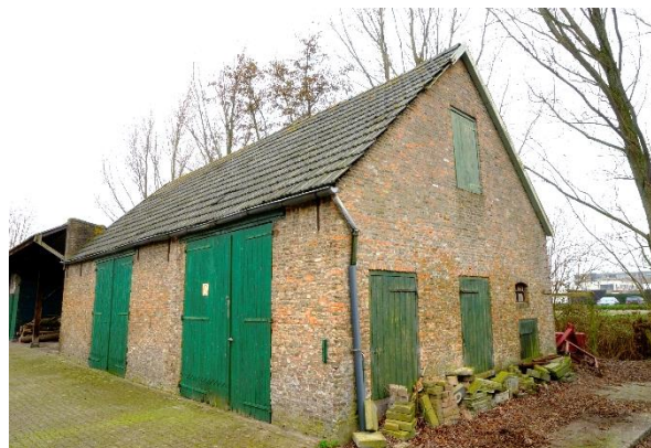
Schuren naast de kapschuur
