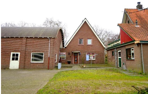
Achterste woning en werkloods
