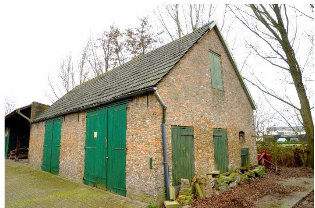
Schuren naast de kapschuur
