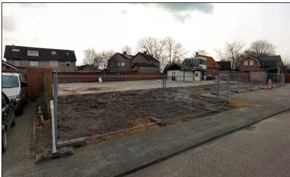
Aanzicht vanaf de Lijsterbesstraat, met de inmiddels verwijderde beplanting en gesloopte bedrijfsbebouwing binnen het plangebied. Bron: Cyclomedia, 13 maart 2017.
