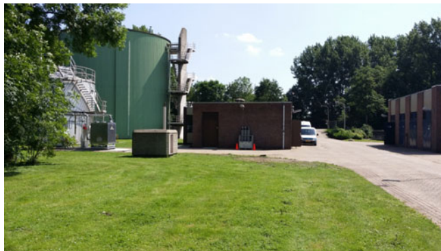
Foto 2: terrein van de waterzuivering met op de voorgrond en rechts op de foto de 2 gebouwen met stootvoegen.
