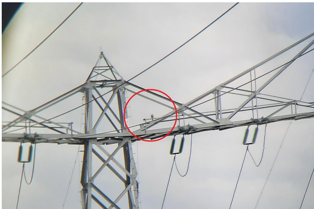
Figuur 8: Slechtvalk (rood omcirkeld) rustend op de meest oostelijke hoogspanningsmast binnen het plangebied. Foto: Mark Bouwmeester | Ecoresult B.V.
