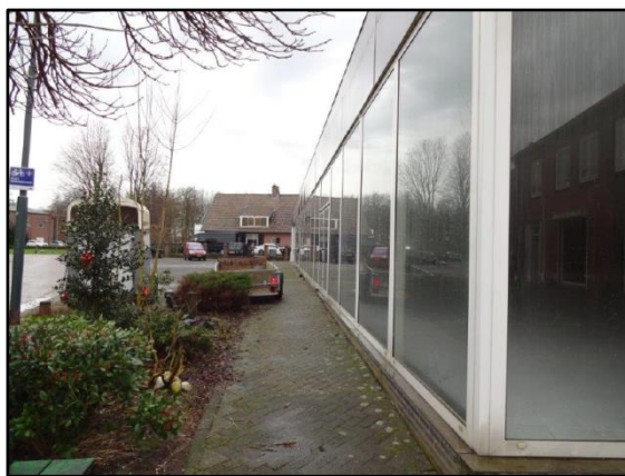
2. Zicht vanuit het noorden, met in de achtergrond de vrijstaande woning.
