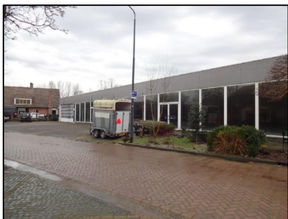
3. Zicht vanuit het noordoosten, met links de vrijstaande woning.
