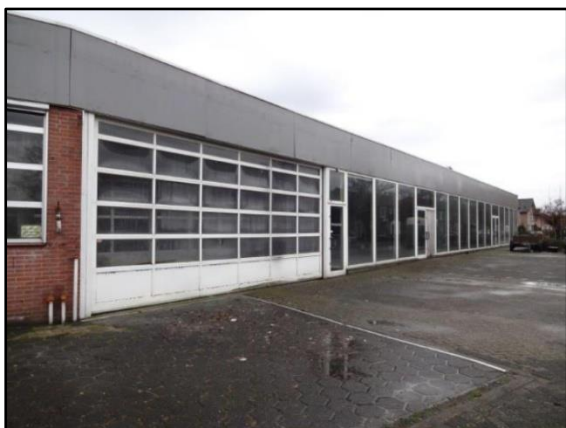
1. Zicht op de voorgevel van het voormalige garagebedrijf.
